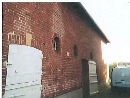
Dépendance avec garage et atelier
